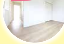
耐震補強 間取り変更
